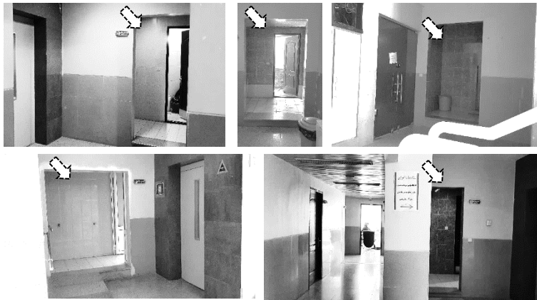
تصویر ۱: جانمایی نامناسب و عدم فیلتراسیون سرویس‌های بهداشتی در تمامی طبقات ساختمان راه و شهرسازی
